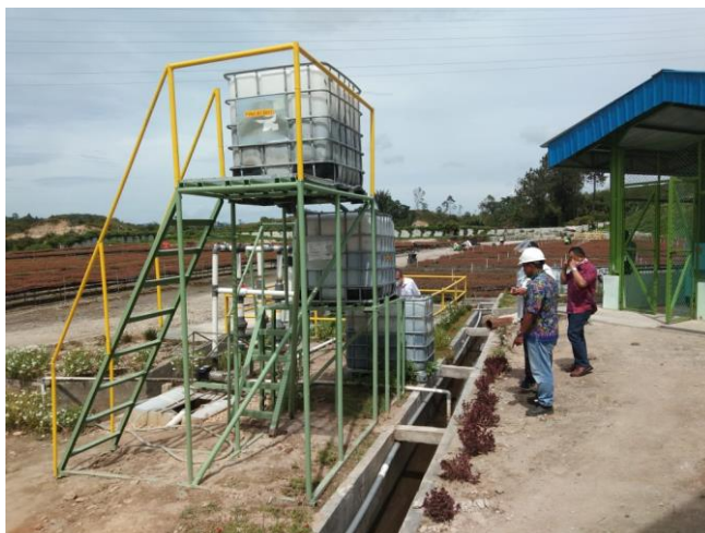
Gambar II-7. Sistem Penyaringan Buangan Air pada IPAL Nursery
