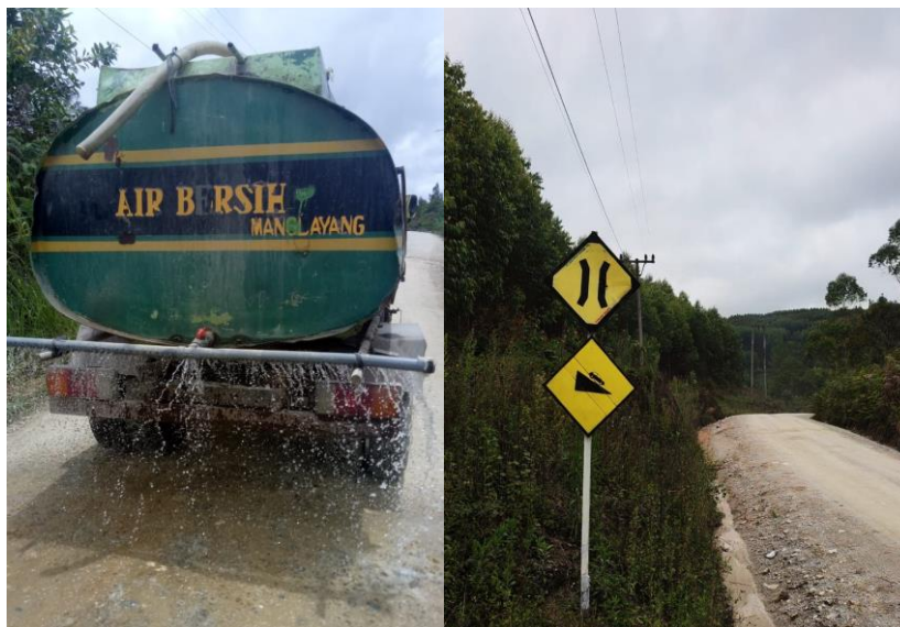
Gambar II-20. Penyiraman Jalan dan Rambu-Rambu Jalan
